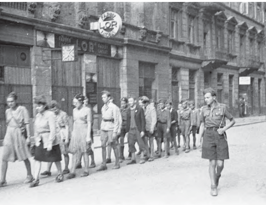
Grupa harcerzy przy budynku na ulicy Żłotej 6
